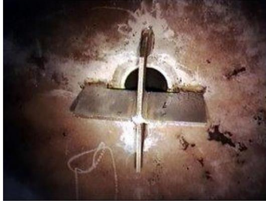
**FIGURE 29. Vortex Breaker (Processing, 2008)**
